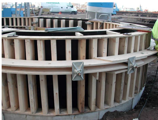
Centerpenconstructie met verloren middengedeelte en verloren (beton) conussen
